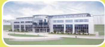
Werk 1, Produktion mit Verwaltungsgebäude und Schulungszentrum
